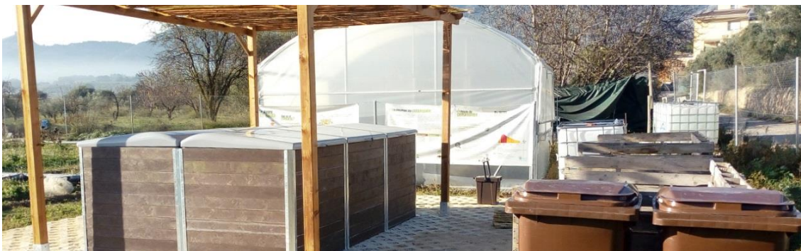
Compostera construida por la Diputación de Alicante
